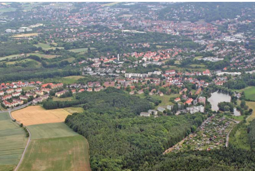
Abb. 13.4.2 Wüstenahorn: Blick von Süden
